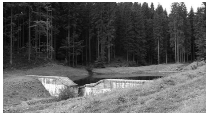
Bedřichův klauz na Bílé byl v letech 2003–2005 opraven
