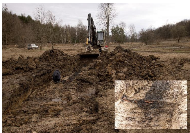
Odstraňování melioračních drenáží jaro 2023
