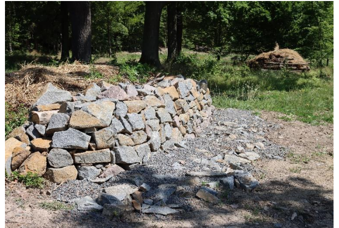
Dokončené plazníky červenec 2023
