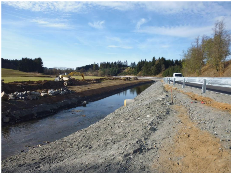
Obr. VII Napřímené koryto Bobrůvky u Bobrové
